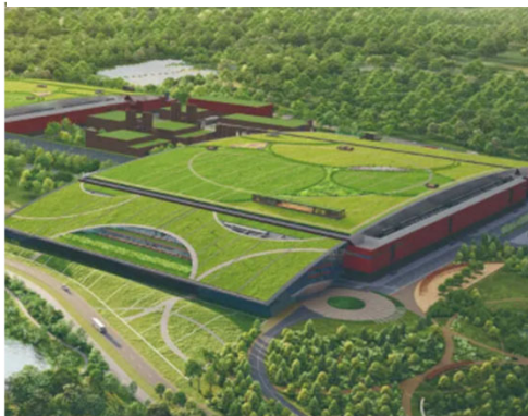
<次世代半導体工場>
