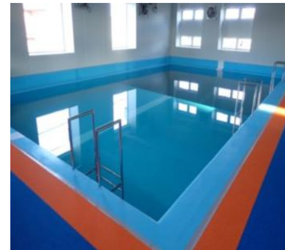
(写真) 大歩プール。最大水深5mを有するが、落水訓練のため施設の一部改修工事が必要
